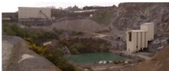
Concasseur bardé sur le site de Tréguieux
